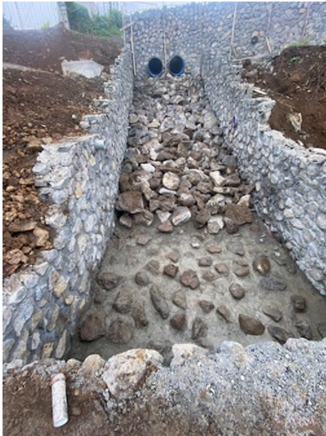
Figure 23 - exemple de protection mis en oeuvre
