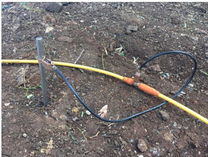
Figure 5 : Électrode, connecteur bretelle et câble ERT (jaune) (Stratagem974).
