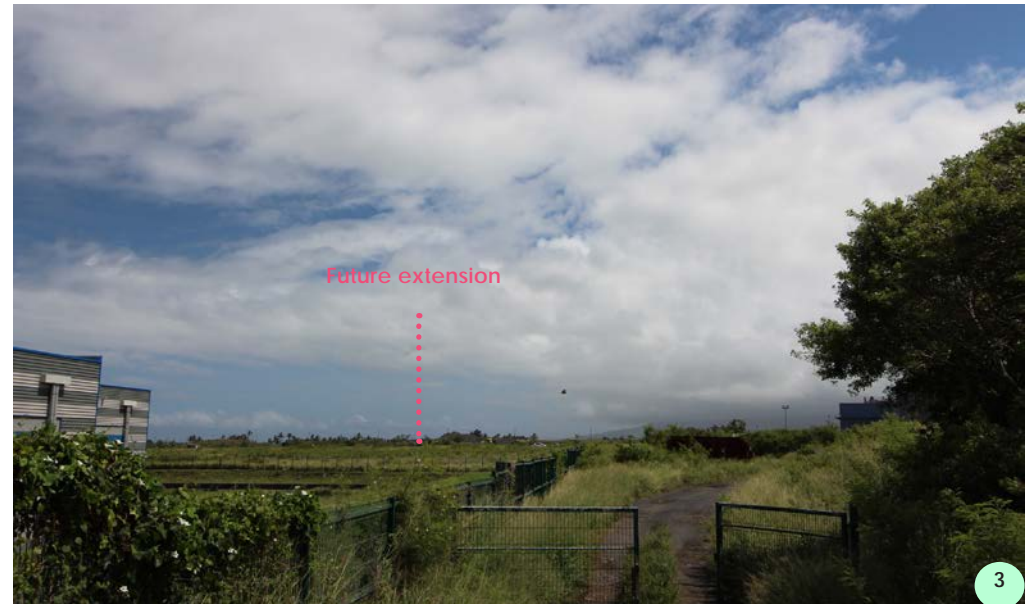
FIGURE 24 - VUE DEPUIS LE CHEMIN DE L'AÉRODROME
