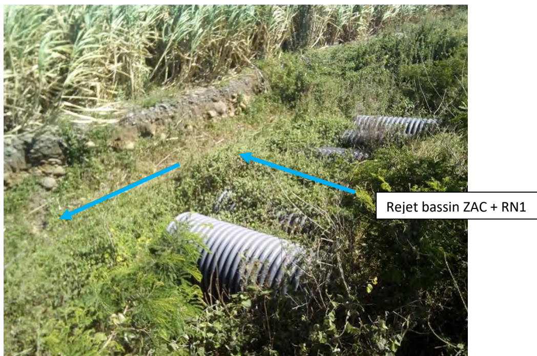
Figure 10 - Ouvrage en sortie de ZAC
