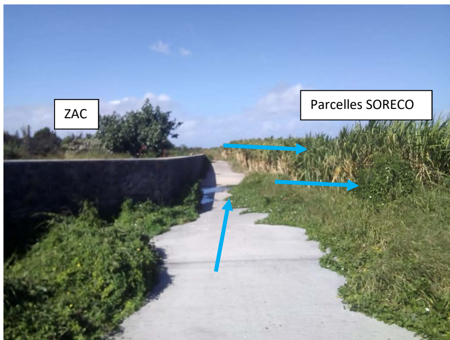
Figure 12 - Canal diffuseur partie aval
