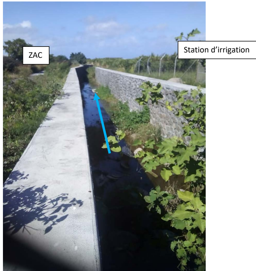
Figure 11 - Canal diffuseur partie amont
